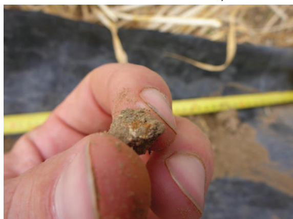
S24 : Dégradation de la meulière
